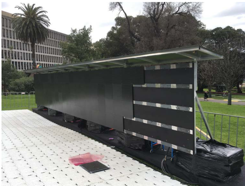
Mur Waterlight Graffiti de 10 mètres de long et 1,60 mètres de haut avec toit
